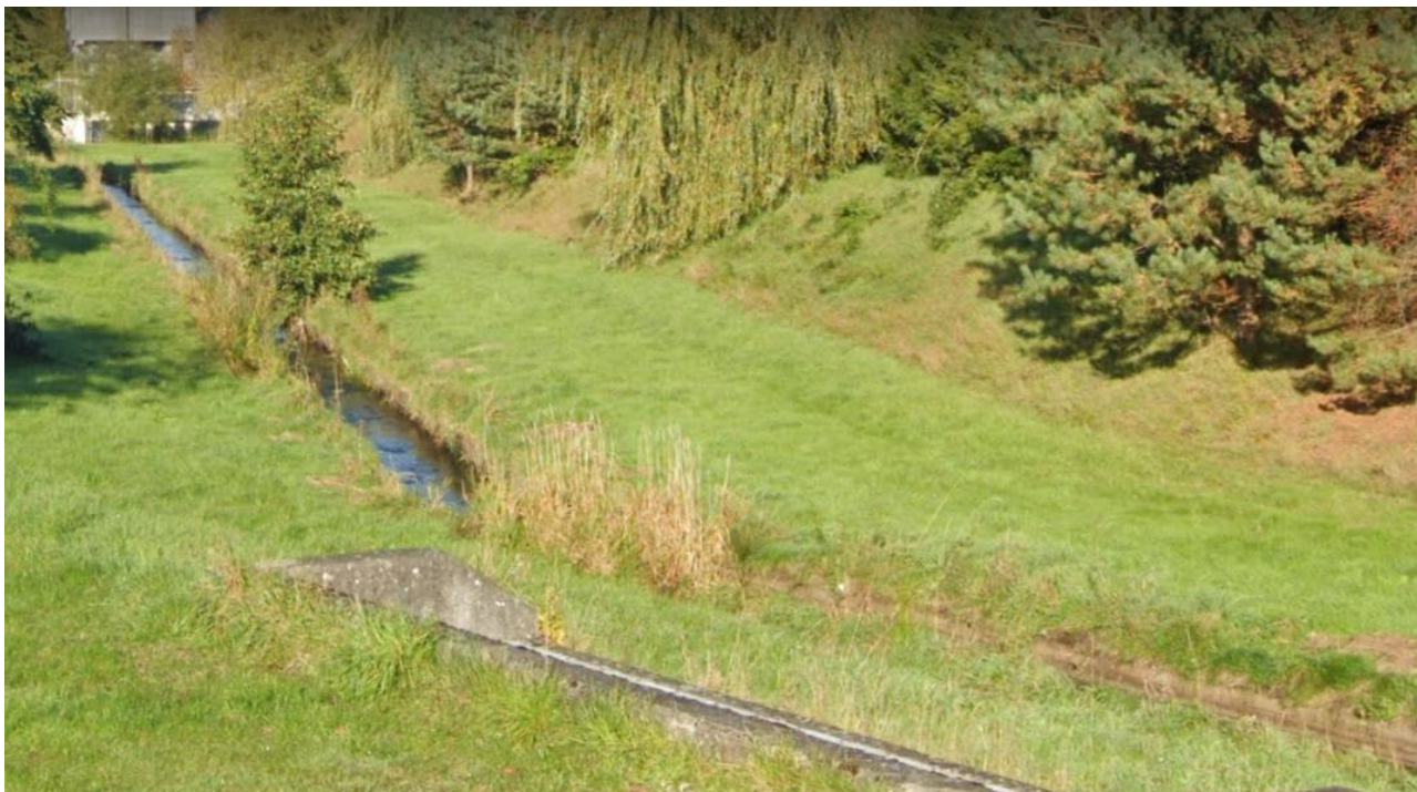
Figur 11. Udsnit af Pøle Å med å løb igennem Hillerød ved Hillerødholmsalle. Som det kan ses, har åen lange lige stræk med store nedstik og betondækning på den ene side af åen.
