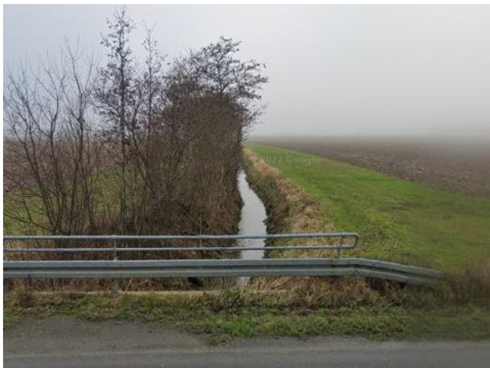
Figur 31. Ågeby å passage ved Nødbøllevvej. Her ses meget dybt nedstik samt tydelig kanalisering.
